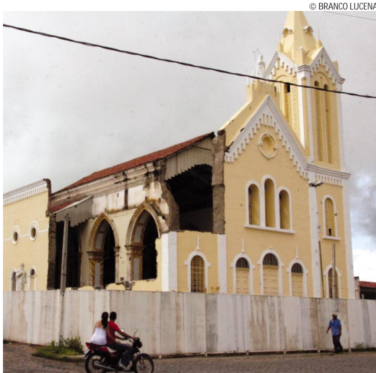
Parte do prédio da igreja matriz de Sousa passa por restauração no momento
