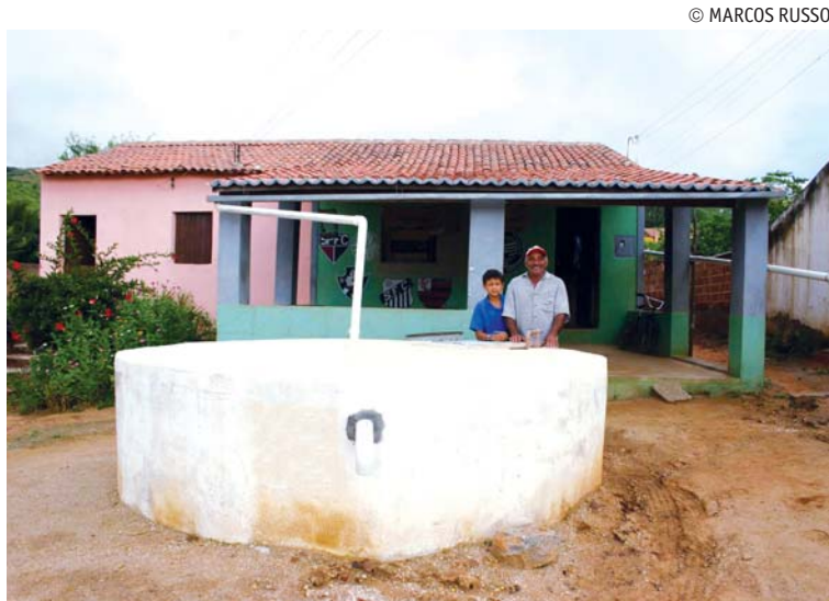
Cisterna de placa se encontra inserida em projetos aprovados pelo Funcep
