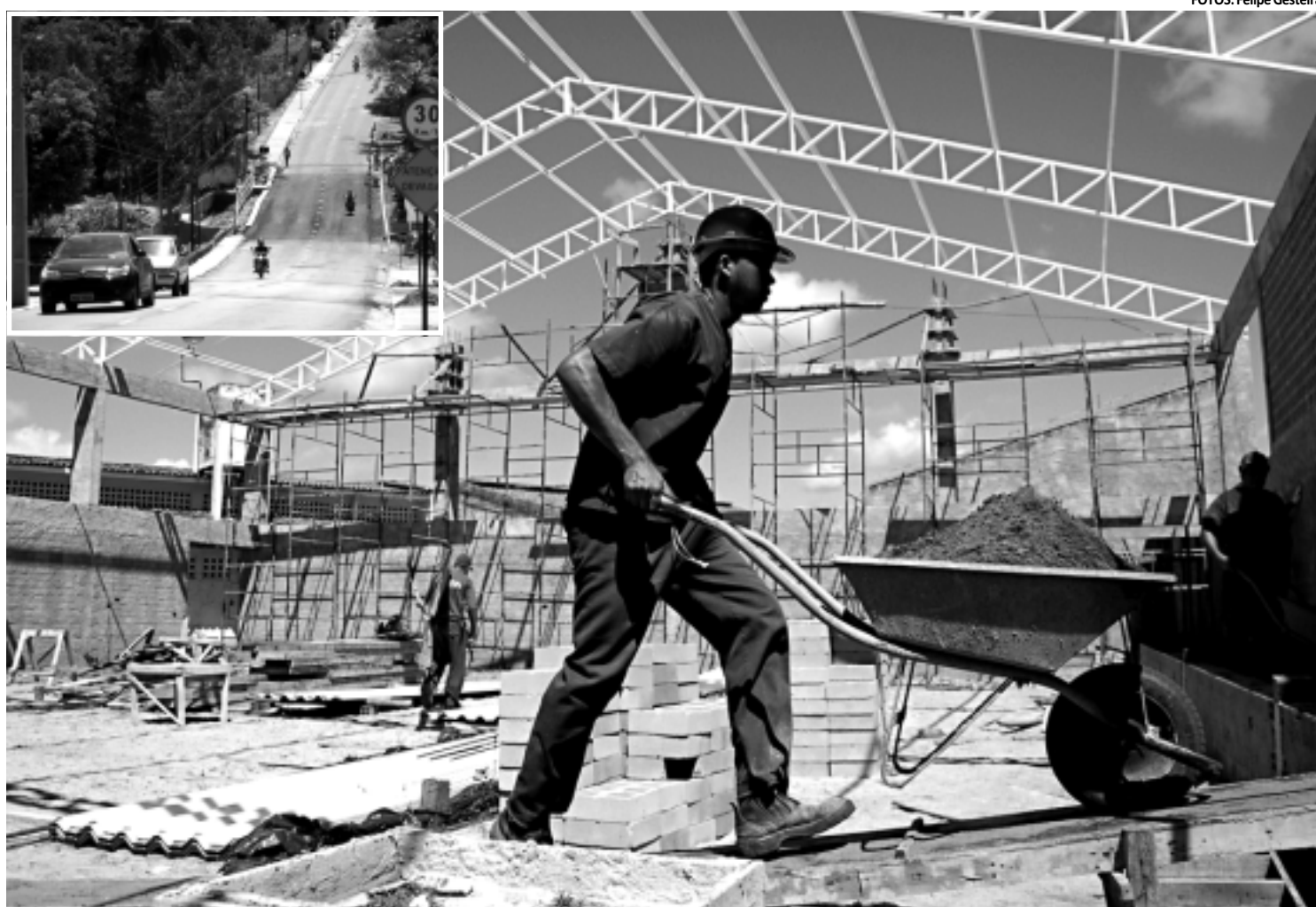
Operários erguem prédio de ginásio de esporte em bairro de João Pessoa, a avenida Boto de Menezes (no detalhe acima) recebeu pavimentação
