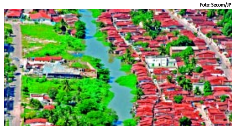
A obra de urbanização está orçada em R$ 193 milhões
