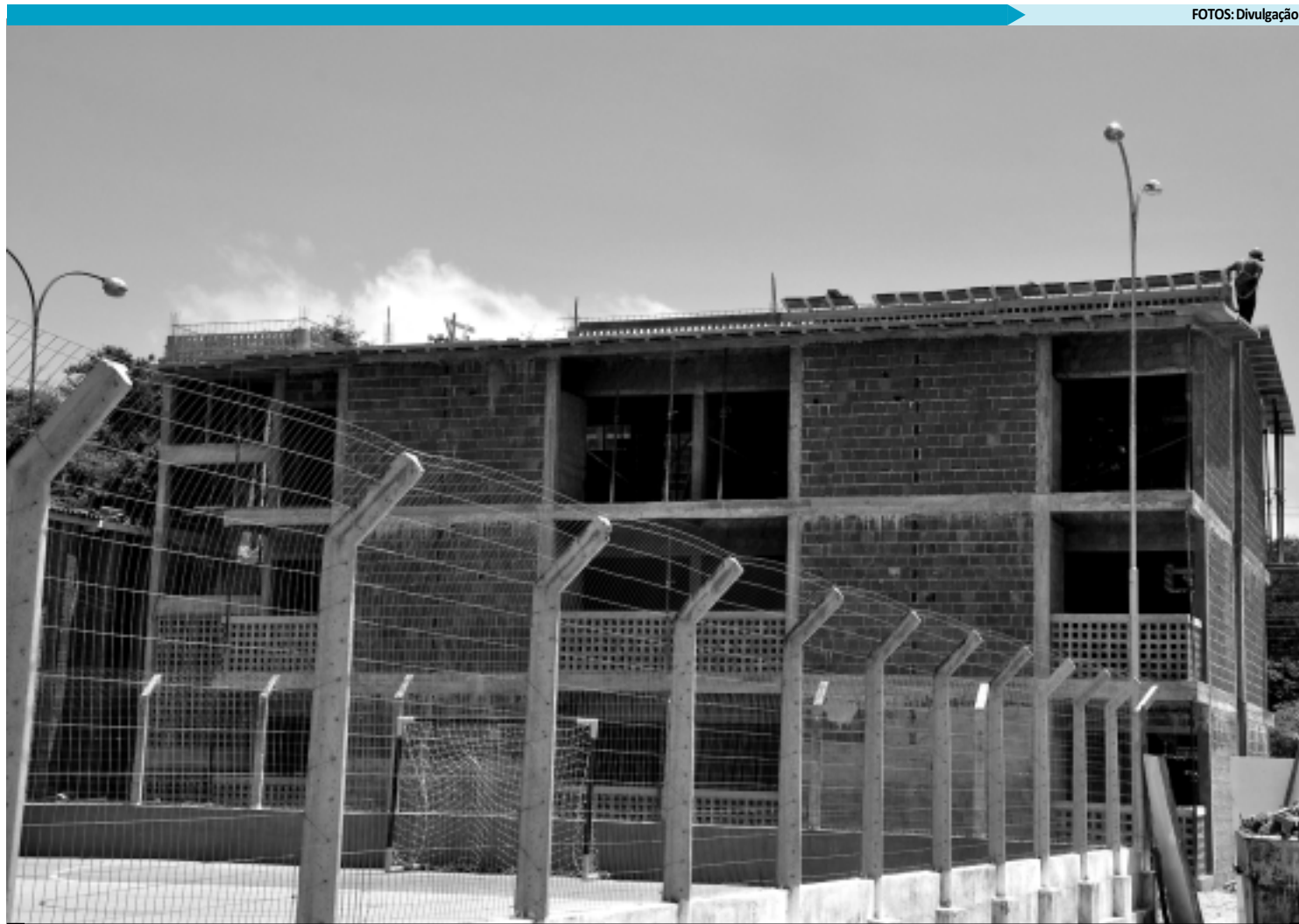
O local onde aconteceu o acidente na UFPB faz parte da ampliação pelo Reuni. Trabalhadores sem cinto de segurança caíram de uma altura de 10 metros
