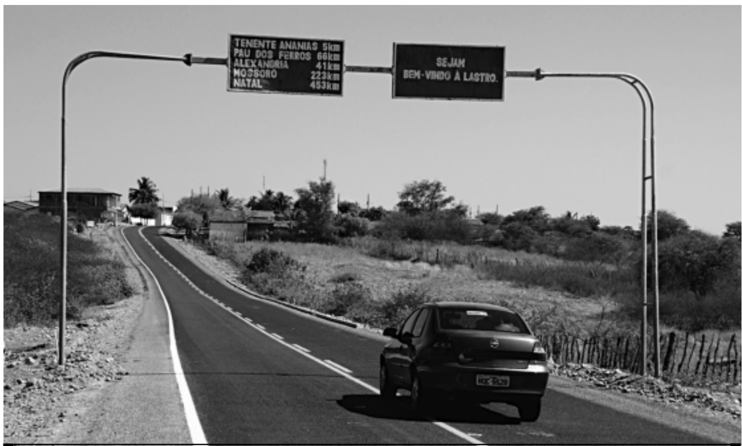
A pavimentação da rodovia, denominada Marizinho Abrantes, era um antigo sonho dos moradores de Lastro e Sousa, que agora se concretiza
