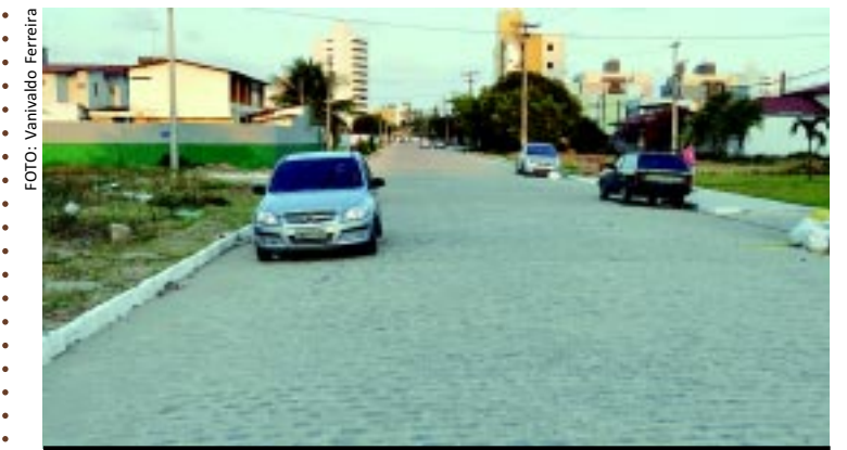
[FOTO&LEGENDA] As obras de pavimentação e drenagem executadas pelo Governo Estadual no bairro do Bessa estão em fase final. A próxima etapa será a conclusão do canal do Bessa e do asfalto da Avenida Paulo Roberto Acioly, encerrando a etapa no bairro.
