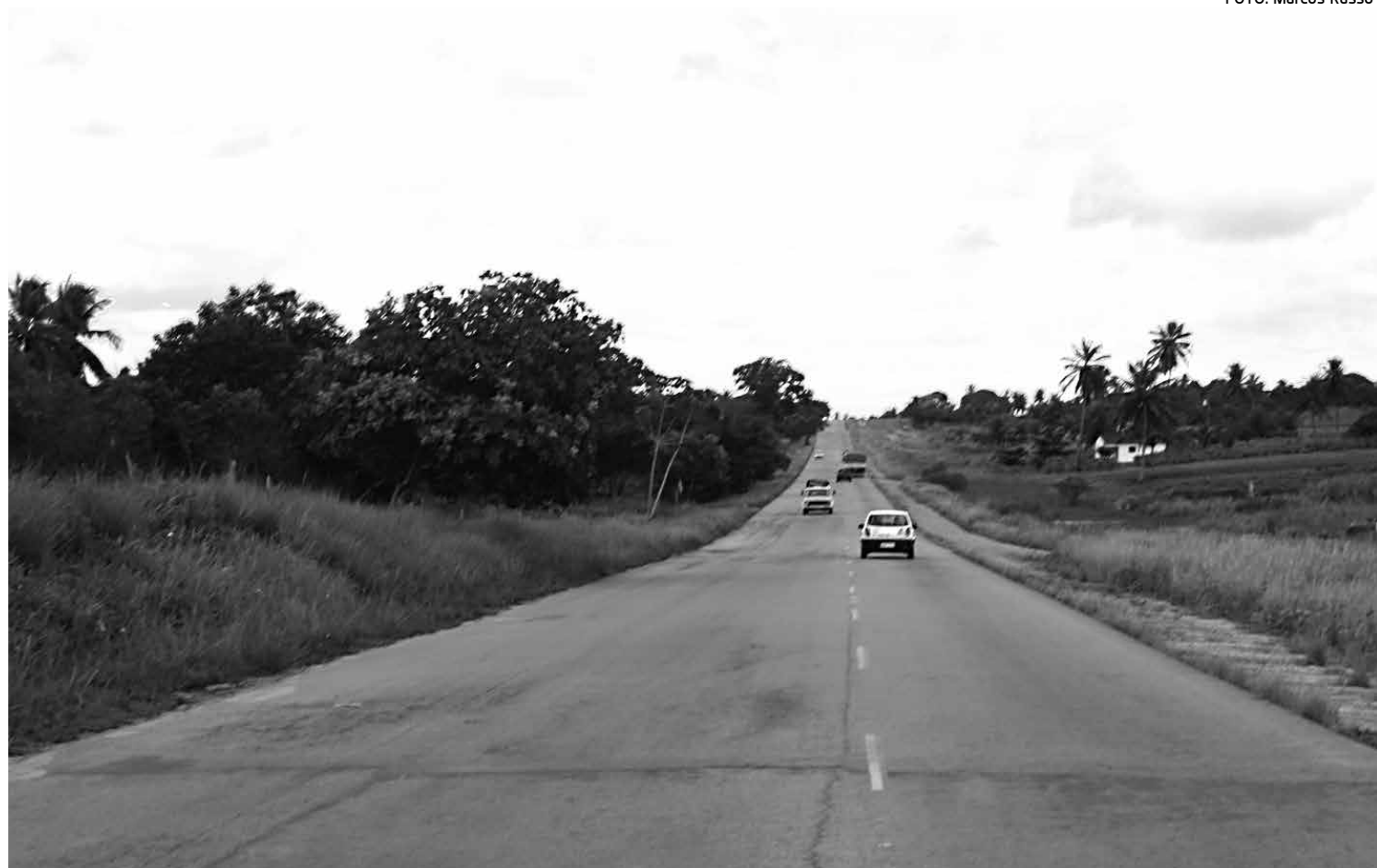
A Superintendência do Dnit informou que as obras de duplicação da rodovia serão realizadas num trecho de mais de 300 quilômetros
