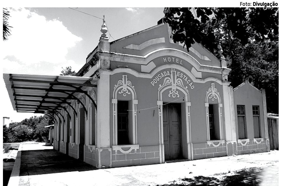
Terminal de Bananeiras também foi recuperado e virou o Hotel Pousada da Estação
