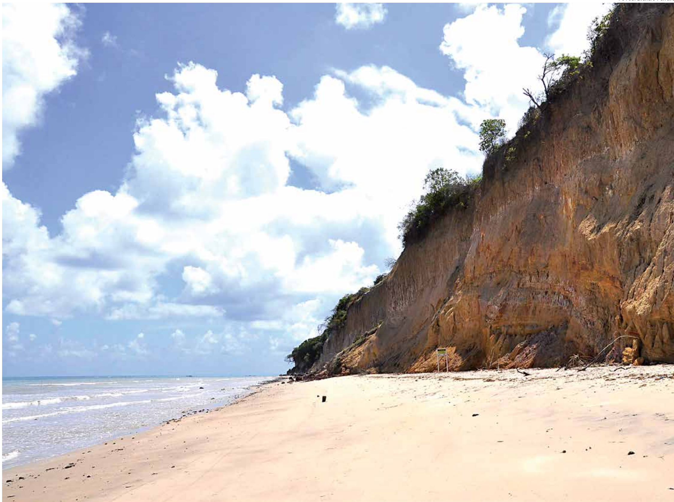
Localizada no ponto extremo oriental das Américas, a Barreira do Cabo Branco, nos últimos três anos, recuou um metro a cada período de 12 meses, o que aumenta o desgaste e o risco de deslizamento
