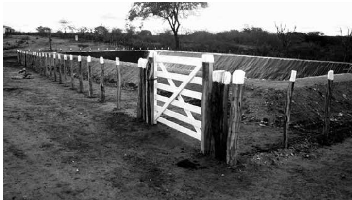
Tanque de contenção do concentrado, que recebe os resíduos
