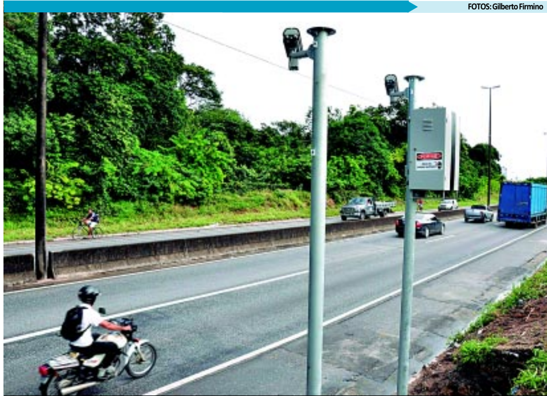
O Departamento Nacional de Infraestrutura e Transportes já começou a instalar os redutores de velocidade
