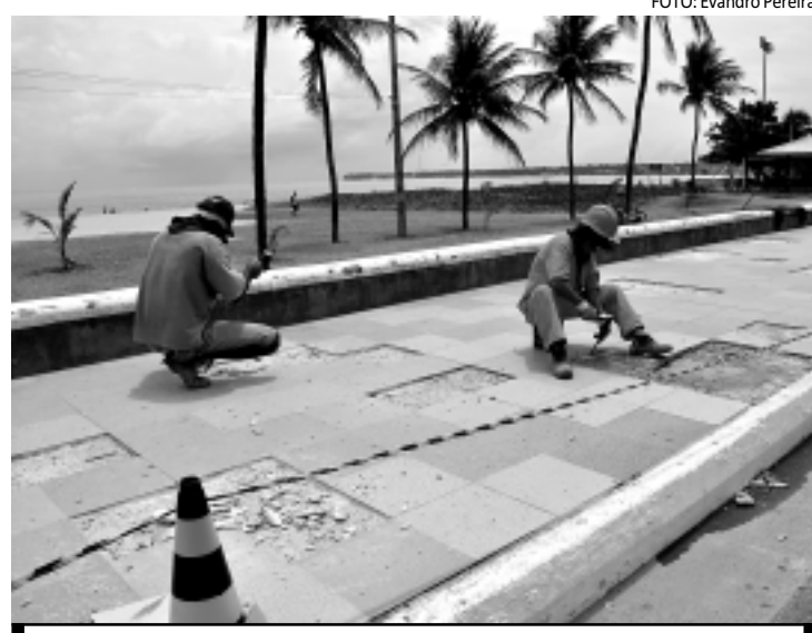
Operários executam obra de recuperação de calçadão na orla da Capital
