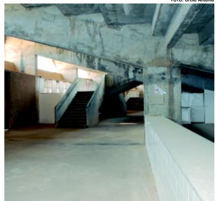
Reforma na parte hidráulica do Estádio Almeida já foi realizada
