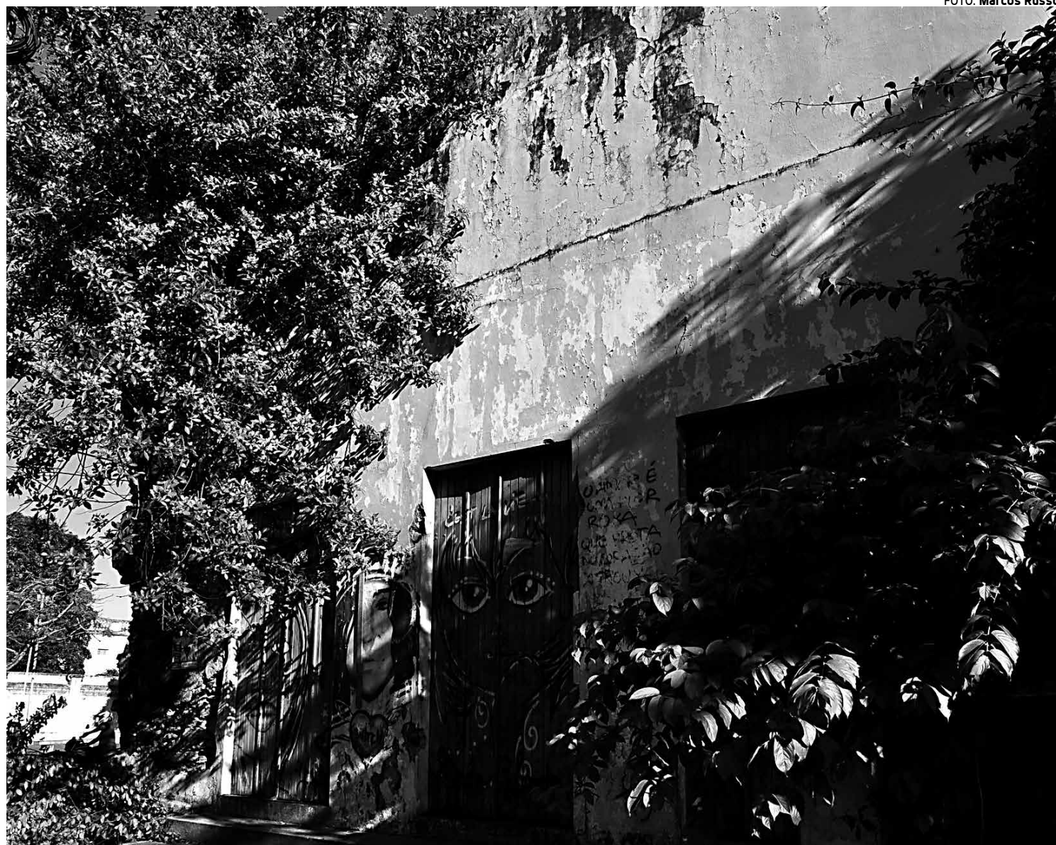
Os trabalhos de recuperação dos prédios na área tombada vão começar com a poda de árvores que cresceram nas fachadas
