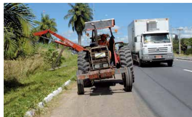
10 máquinas roçadeiras estão sendo utilizadas no serviço
