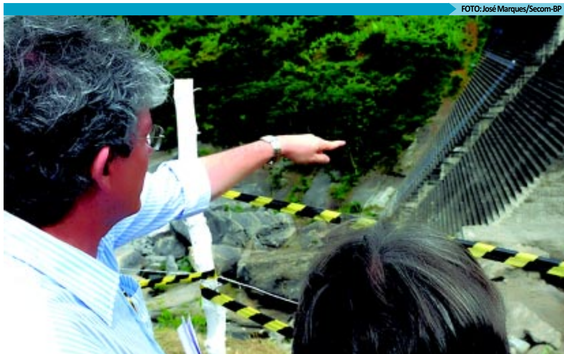
Comitiva do Governo do Estado visitou as obras da barragem Nova Camará, que terão um custo total de R$ 79 milhões
