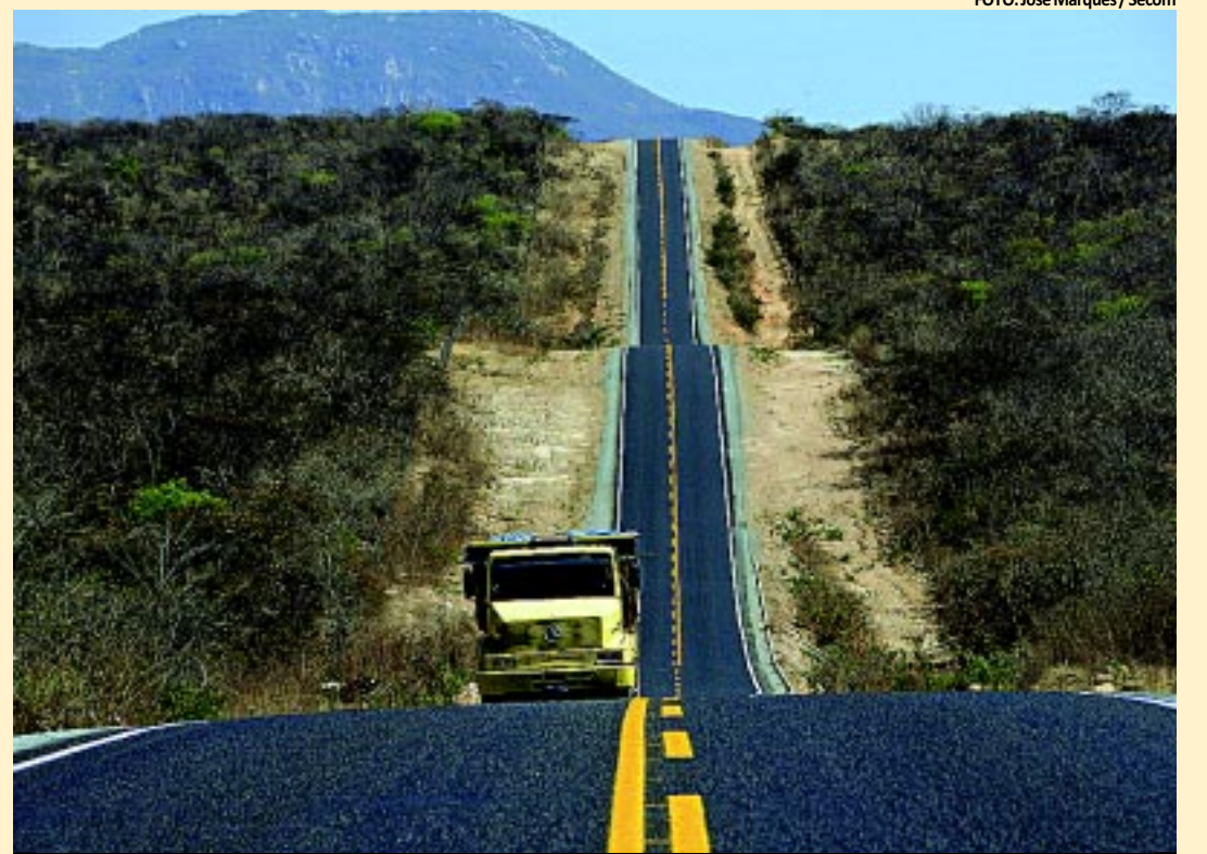
Na BR-405, trecho de Uiraúna a São João do Rio do Peixe, no Sertão paraibano, a obra está concluída.
