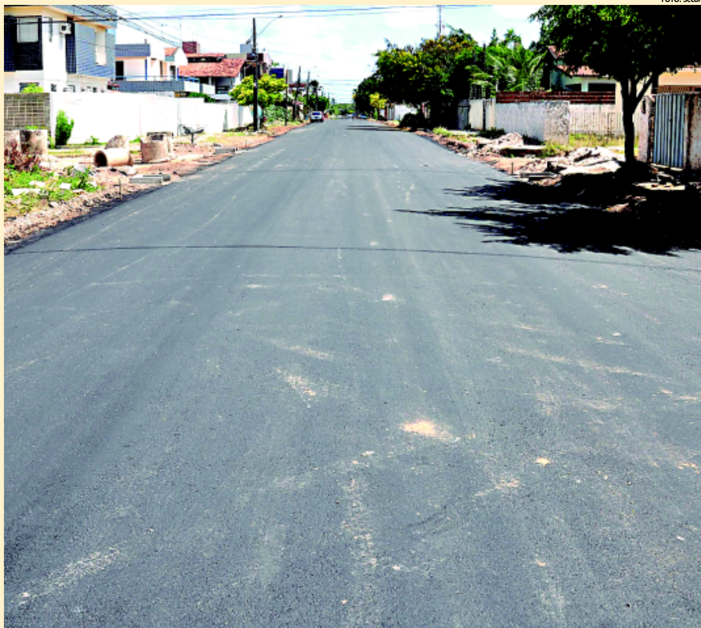
No bairro do Bessa foram executadas ainda diversas obras hídricas, como rede de drenagem e a recuperação de um canal com 217 quilômetros
