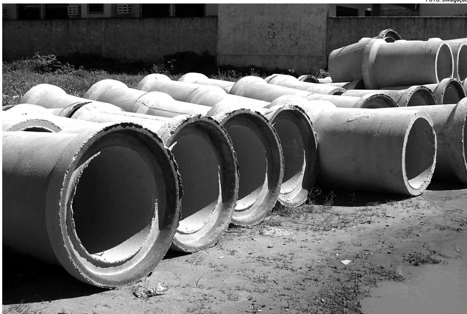
As obras possibilitarão a ligação do esgoto em 37.500 residências, além de promover uma melhoria na qualidade de vida
