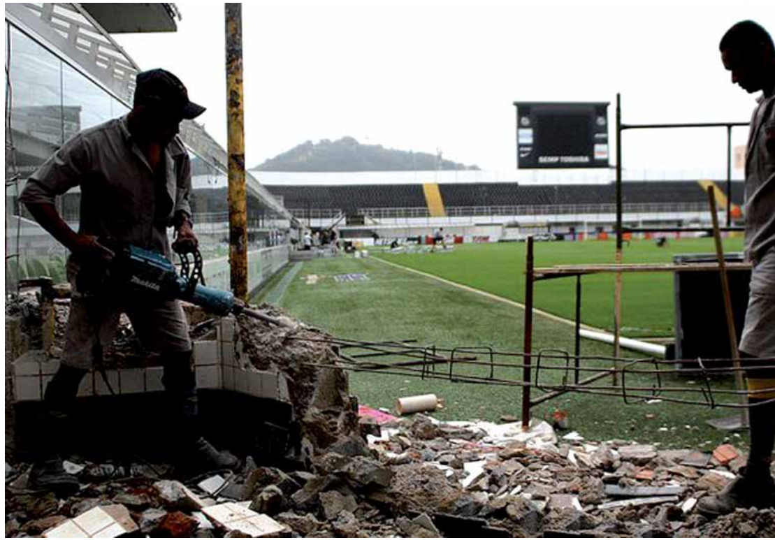
Ontem o Santos deu início às obras de sua praça de esportes para a entrada de ambulâncias
