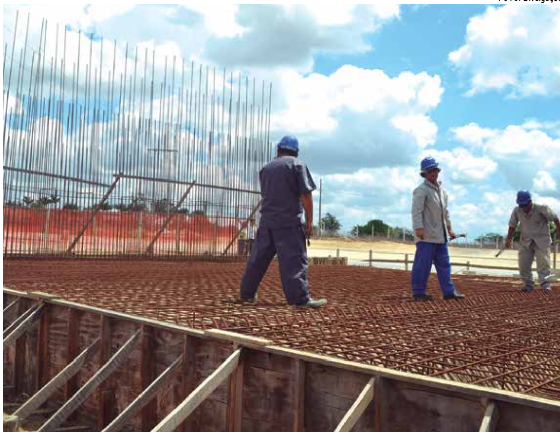
Operários já trabalham na duplicação da via de 3,5 km que está sendo chamada de Rodoanel
