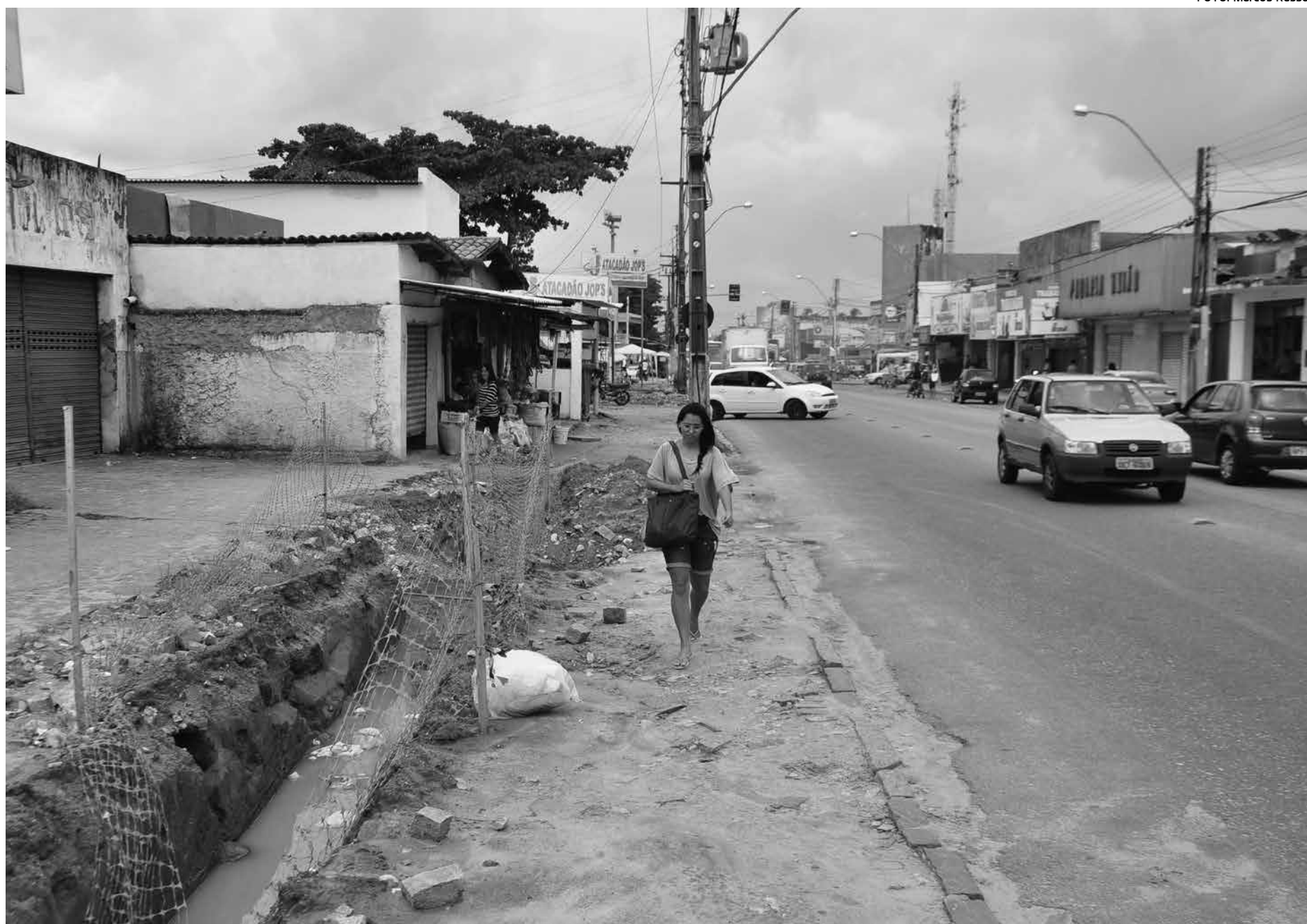
Projeto prevê a relocação de toda a rede de água, esgoto, energia e telefonia existentes do trecho da Avenida Cruz das Armas que está sendo duplicado
