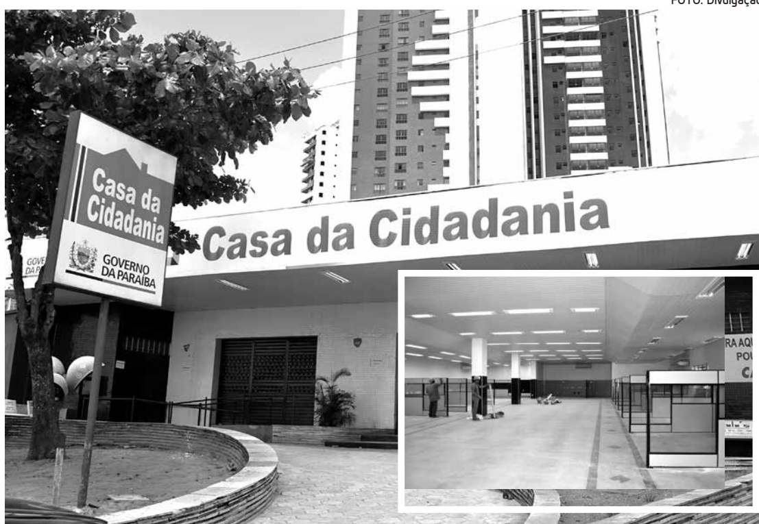
Casa da Cidadania, totalmente reformada (detalhe interno) para sua reinauguração no próximo mês
