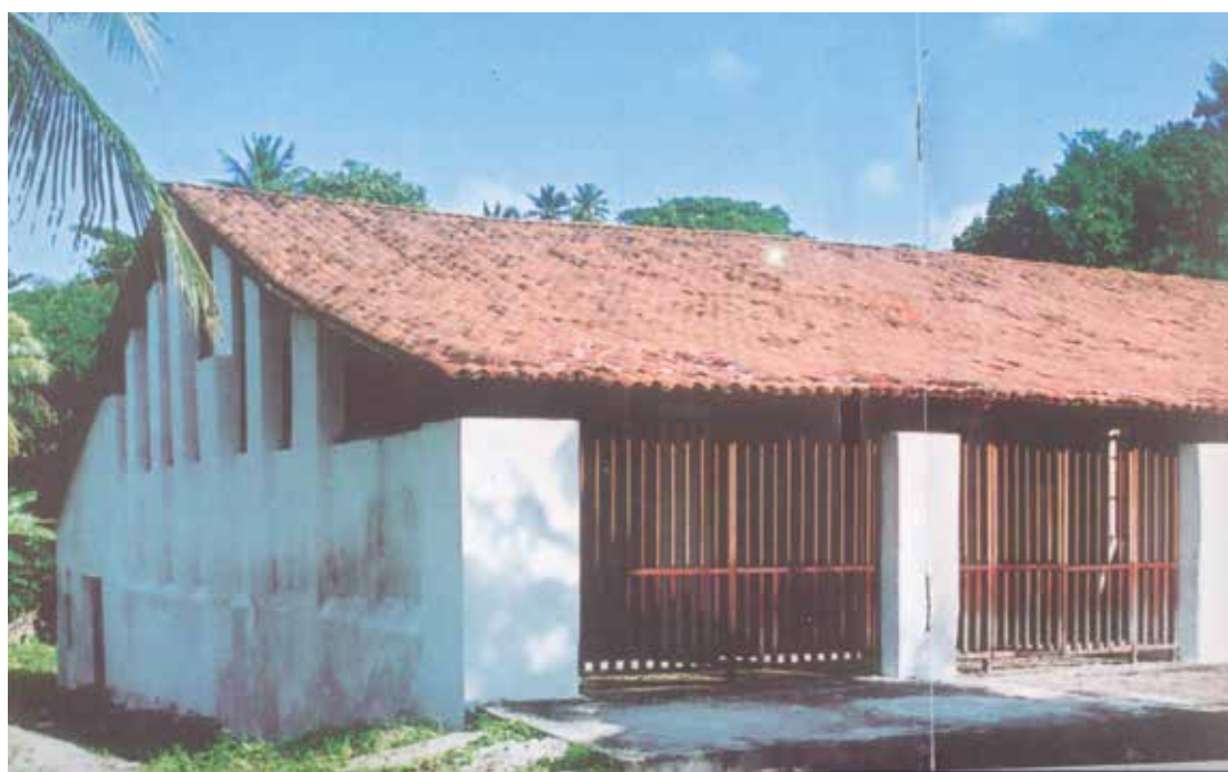
Os trabalhos de restauração do engenho foram realizados pela Oficina Escola de João Pessoa
