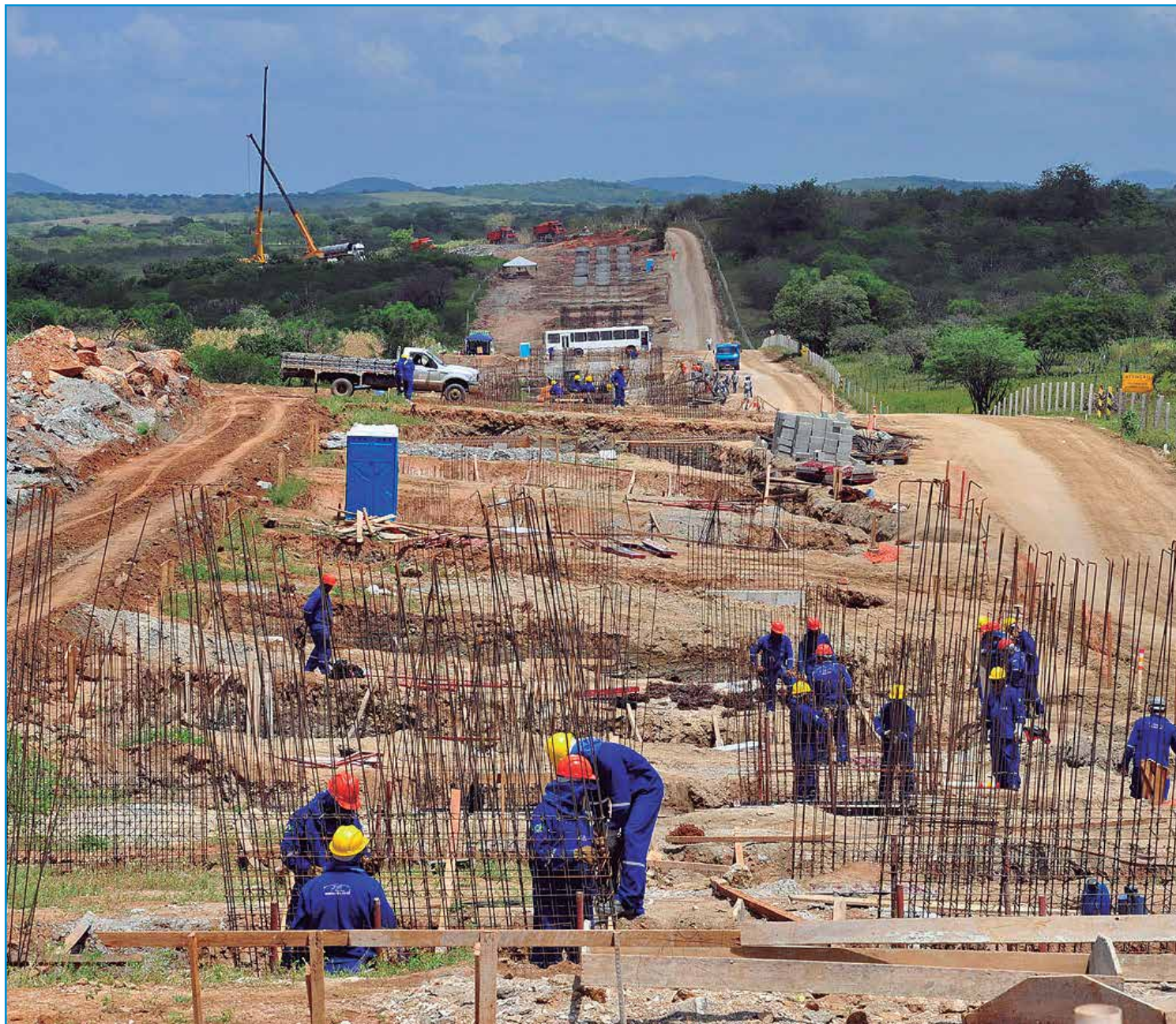
As obras do Canal Acauã-Araçagi já tiveram início e a sua extensão total é de 112,44km. No lote 1 já estão empregadas 1.500 pessoas
