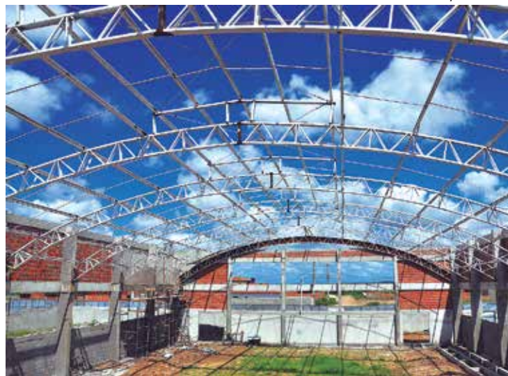
Setenta operários estão trabalhando na obra da unidade de ensino
