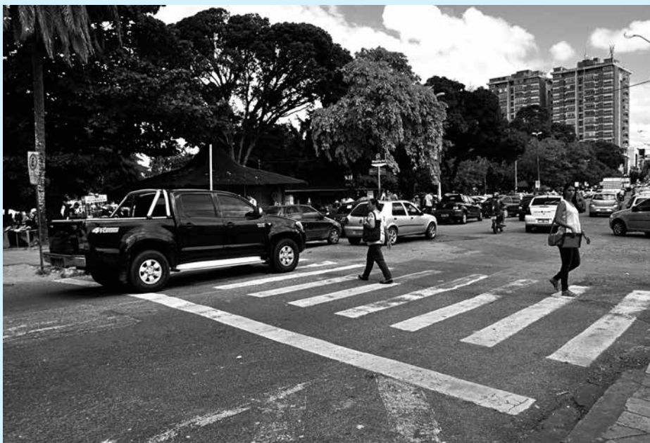
As faixas desgastadas e os veículos colocam em risco a vida dos pedestres
