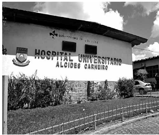
O Hospital Alcides Carneiro é outra unidade de referência
