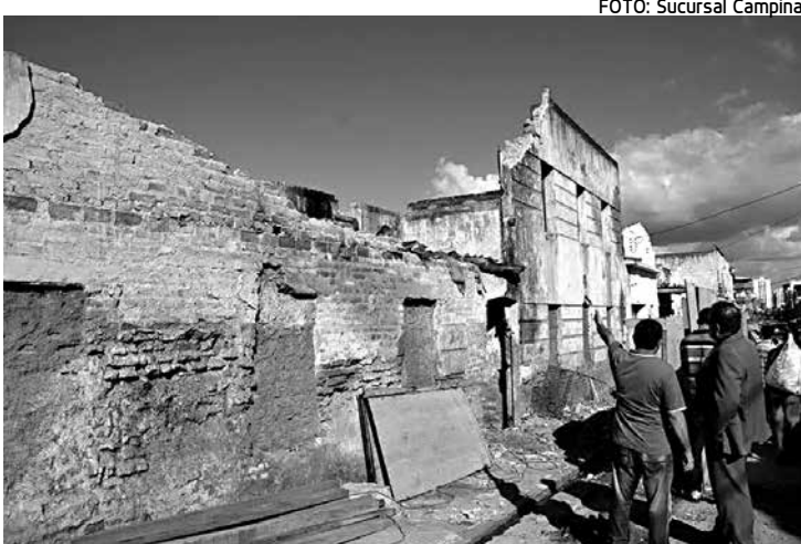
Parte da estrutura do prédio desabou no dia 3 deste mês
