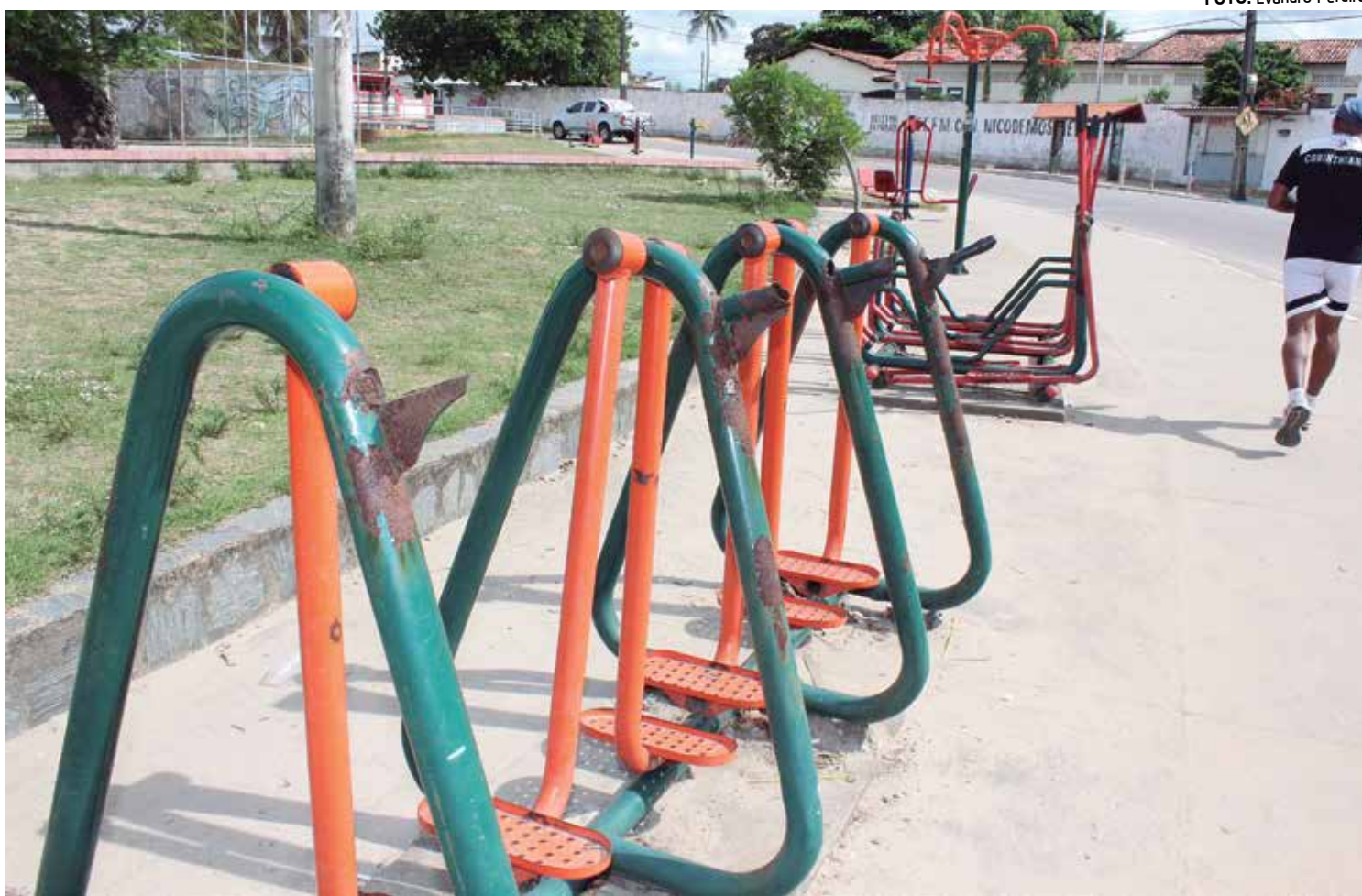
Equipamentos para exercício físico danificados por vândalos em bairro na capital; Emlur e Sedurb acatam denúncias através de telefones
