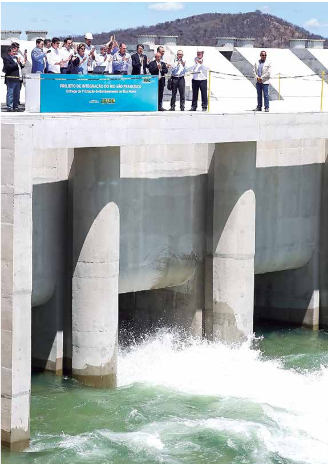
Dilma inaugurou a 1ª estação de bombeamento de água do Eixo Norte da Transposição do São Francisco
