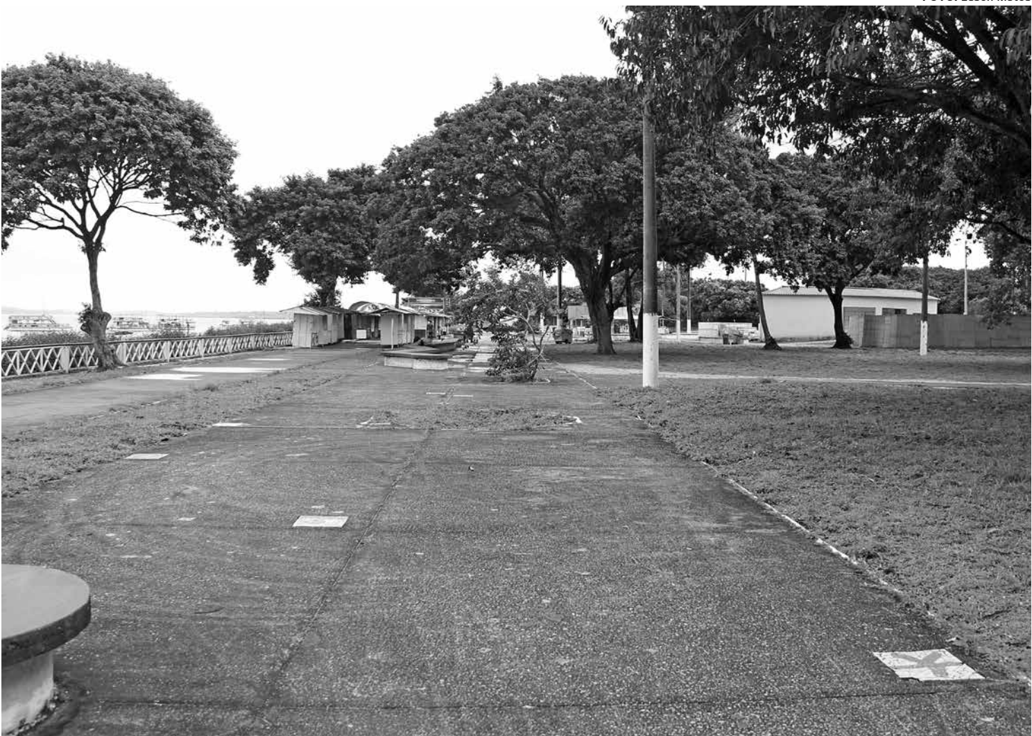
Calçadão da Praia do Jacaré, Cabedelo, onde a obra de construção do muro de arrimo (esquerda) será erguido para proteção da área
