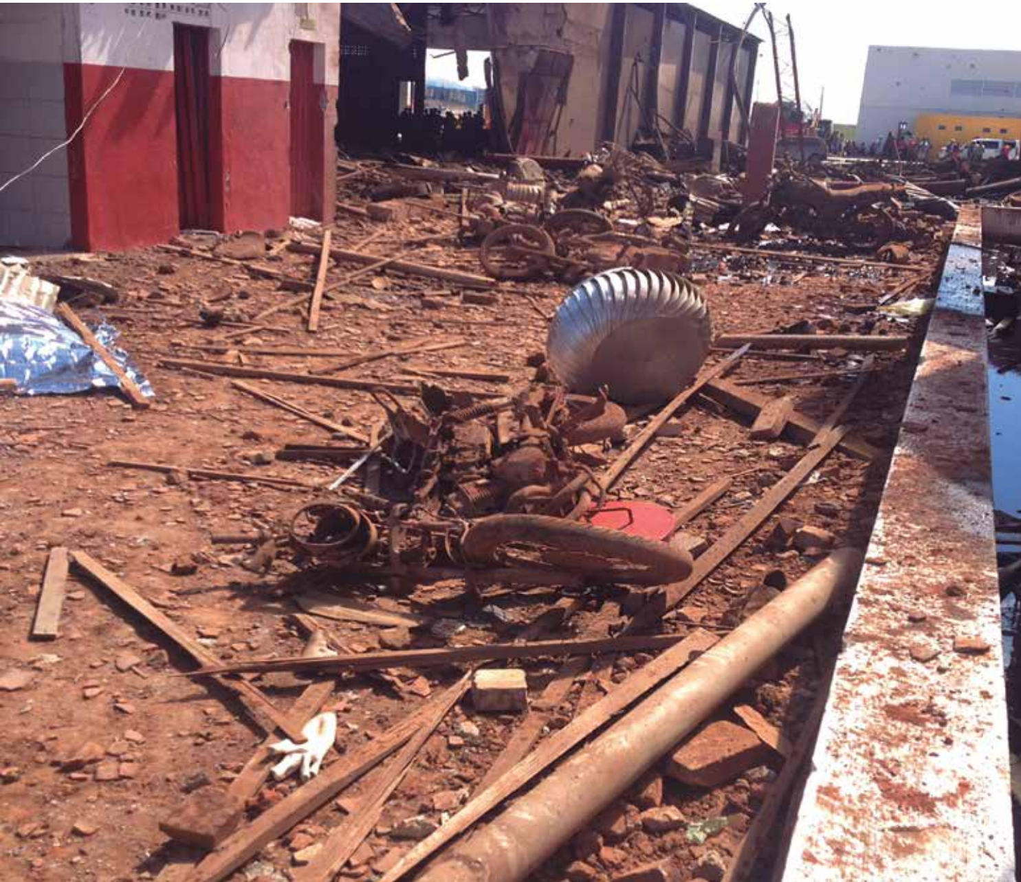
A explosão da caldeira da Torta de Algodão Frei Damião, em Sousa, aconteceu segunda-feira deixando dois trabalhadores mortos
