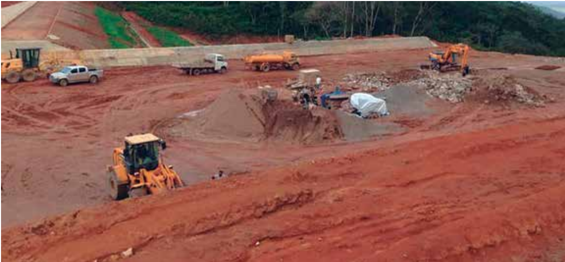
Barragem terá 120 metros de comprimento e capacidade de acumular 2,9 milhões de m³ d'água
