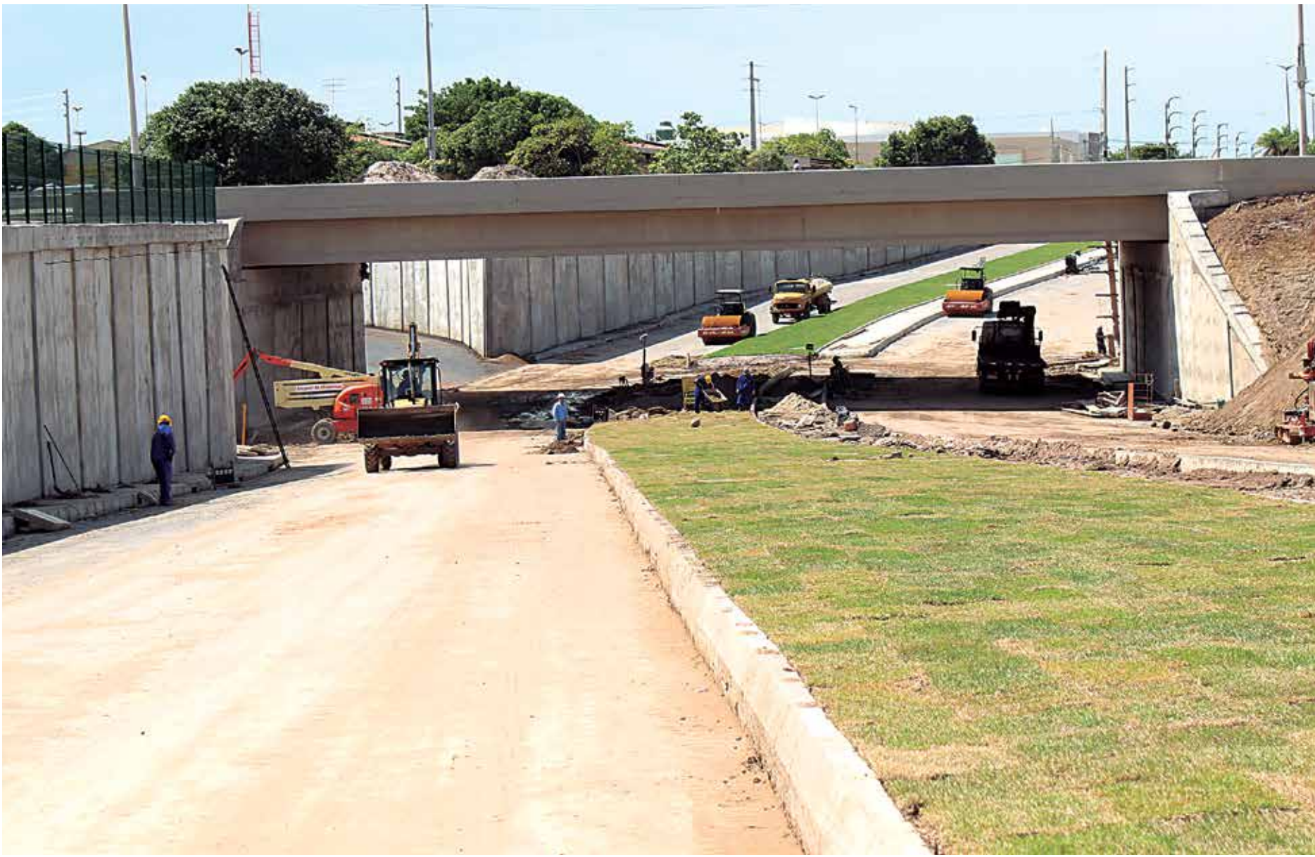
Governo do Estado investiu R$ 25 milhões na obra, que deverá beneficiar 30 mil motoristas que passam diariamente no local, além de 120 mil moradores da região
