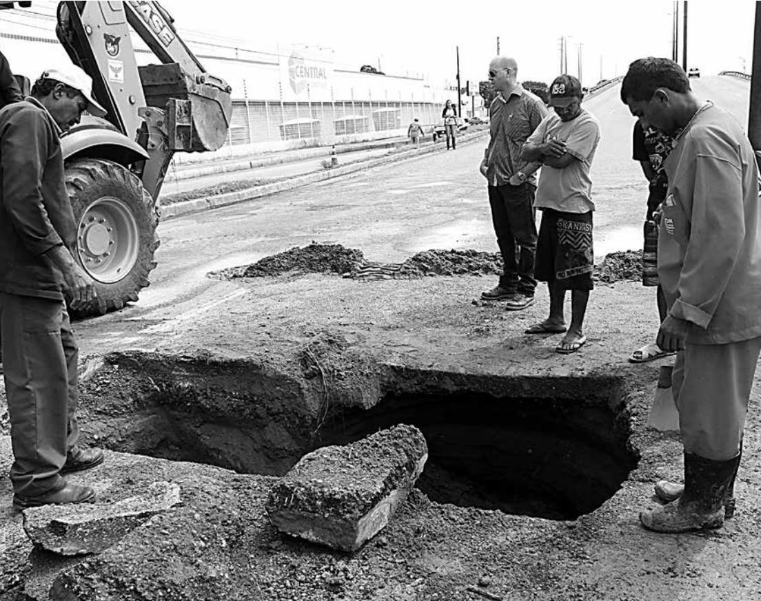
Empresa responsável pelo serviço de manutenção iniciou a recuperação emergencial ainda pela manhã
