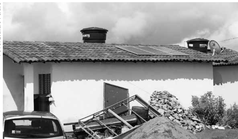
Painéis no telhado fornecem energia e uma economia de 70% no consumo
