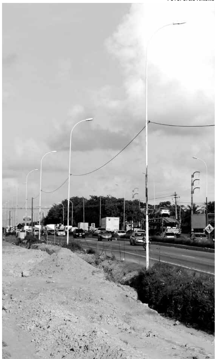
Tronco da rodovia onde os postes já estão sendo deslocados
