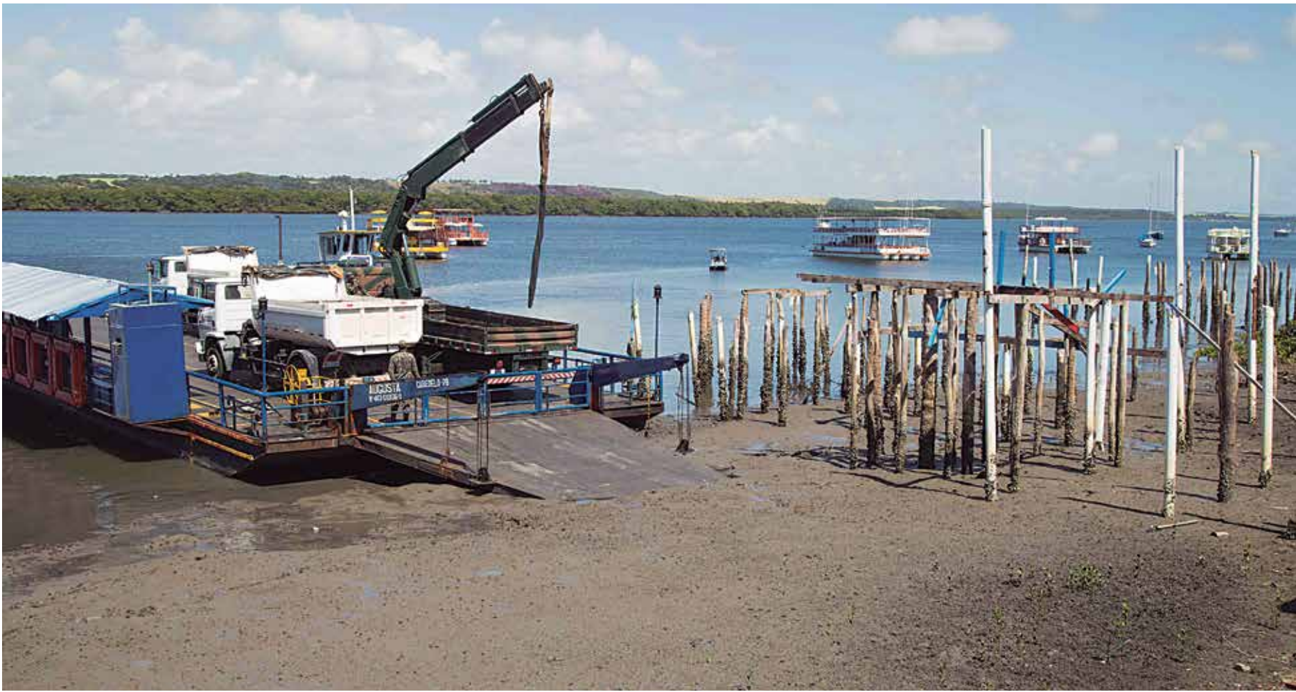
A operação de retirada das estacas deverá ser concluída em 15 dias e está sendo feita em parceria com o Exército e a Capitania dos Portos da Paraíba
