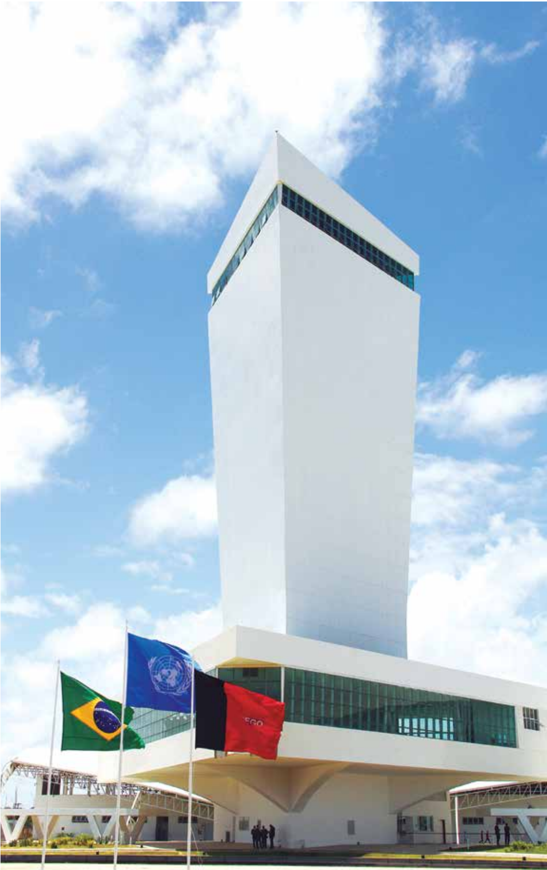
Estrutura do Centro de Convenções foi determinante para a escolha da Paraíba pela ONU
