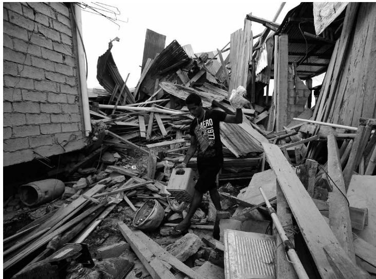
O forte terremoto de magnitude 7,8, ocorrido no último domingo, deixou um rastro de muita destruição em Portoviejo, no Equador
