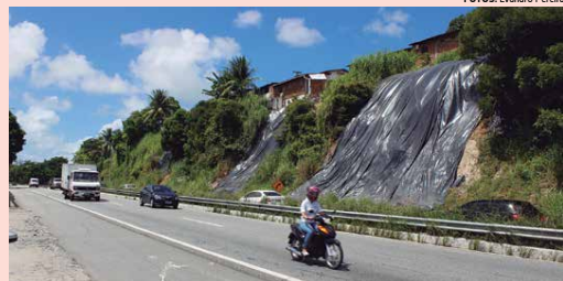
Parte da barreira que desabou sobre uma das pistas da BR-230 está coberta com lona plástica
