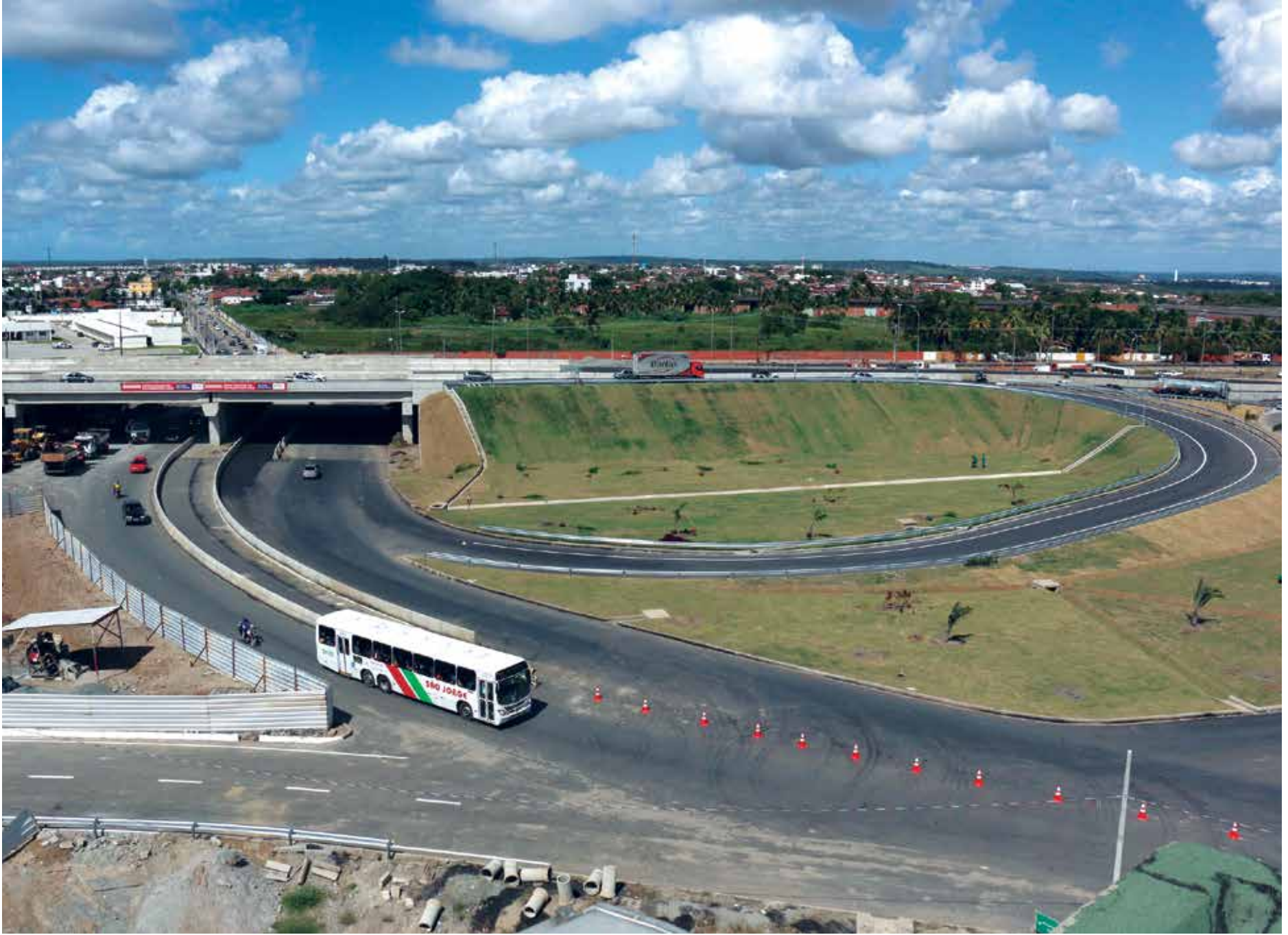
Desde o último sábado, os veículos que trafegam pela BR-230 no sentido João Pessoa/Campina Grande já podem passar por cima do Viaduto do Geisel
