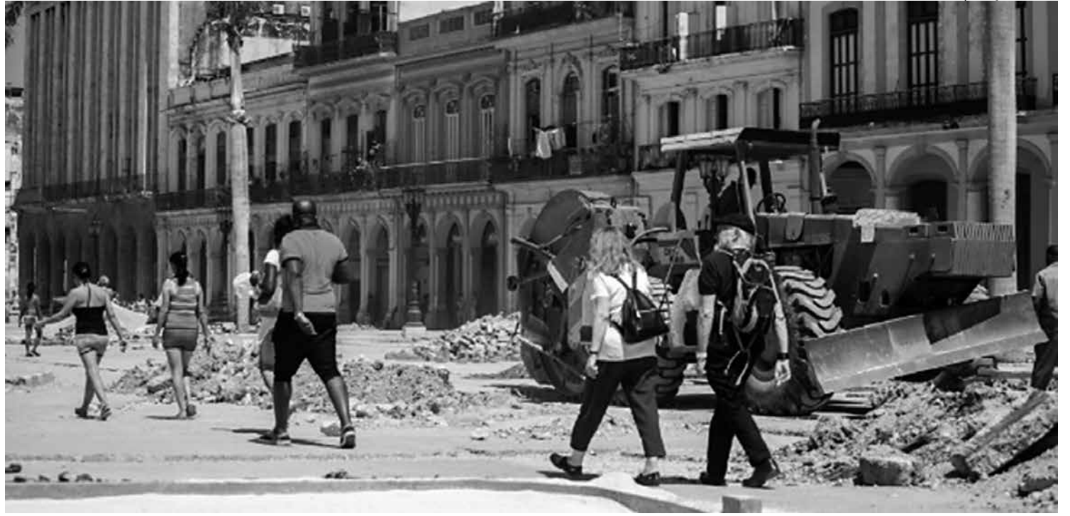
Na capital cubana, são realizadas obras em ruas e monumentos, visando mostrar um novo visual ao presidente Barack Obama
