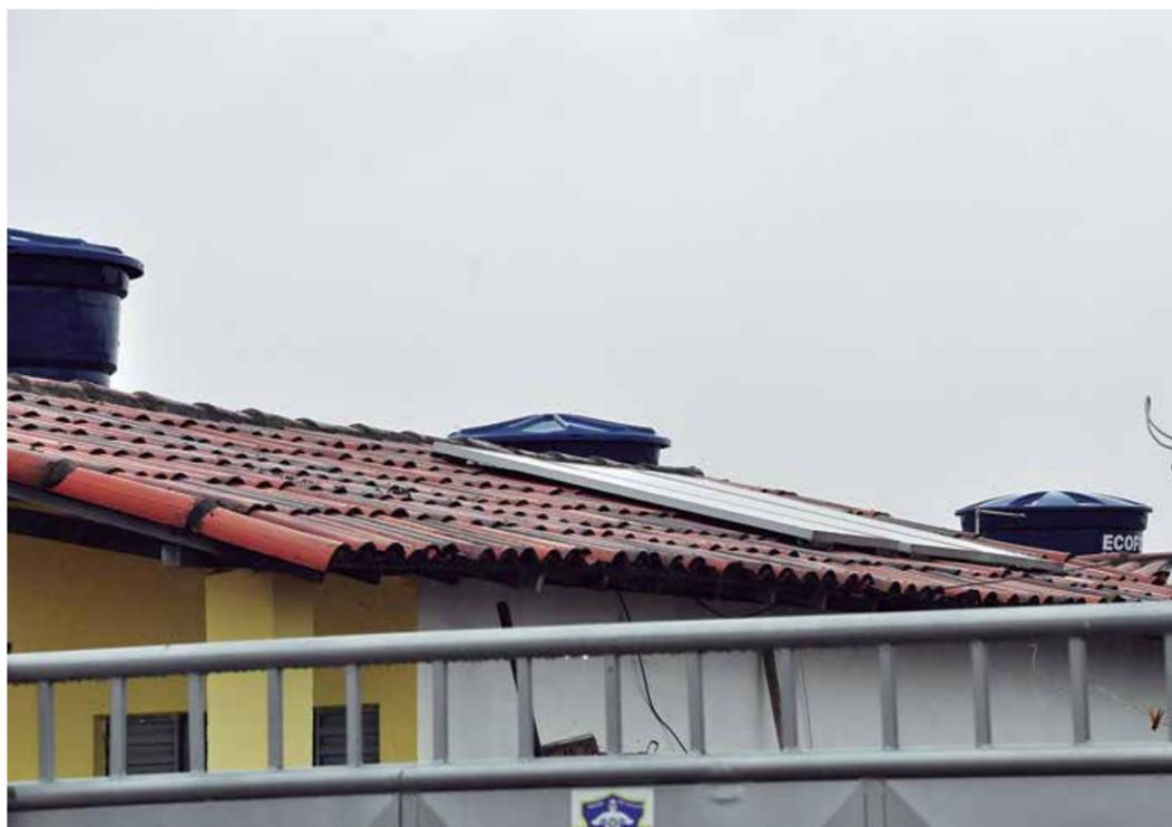
Um dos projetos que vem obtendo resultados positivos em casas populares no Estado é o que utiliza energia solar fotovoltaica, que funciona através de painéis instalados nos telhados e microgeradores no interior dos imóveis
