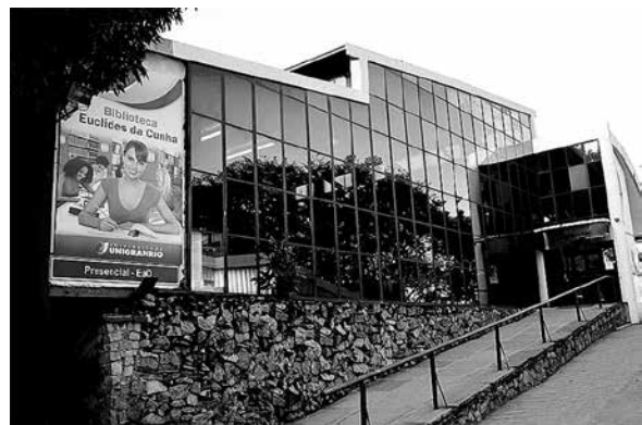
Fachada da Faculdade Cesgranrio, em Duque de Caxias
