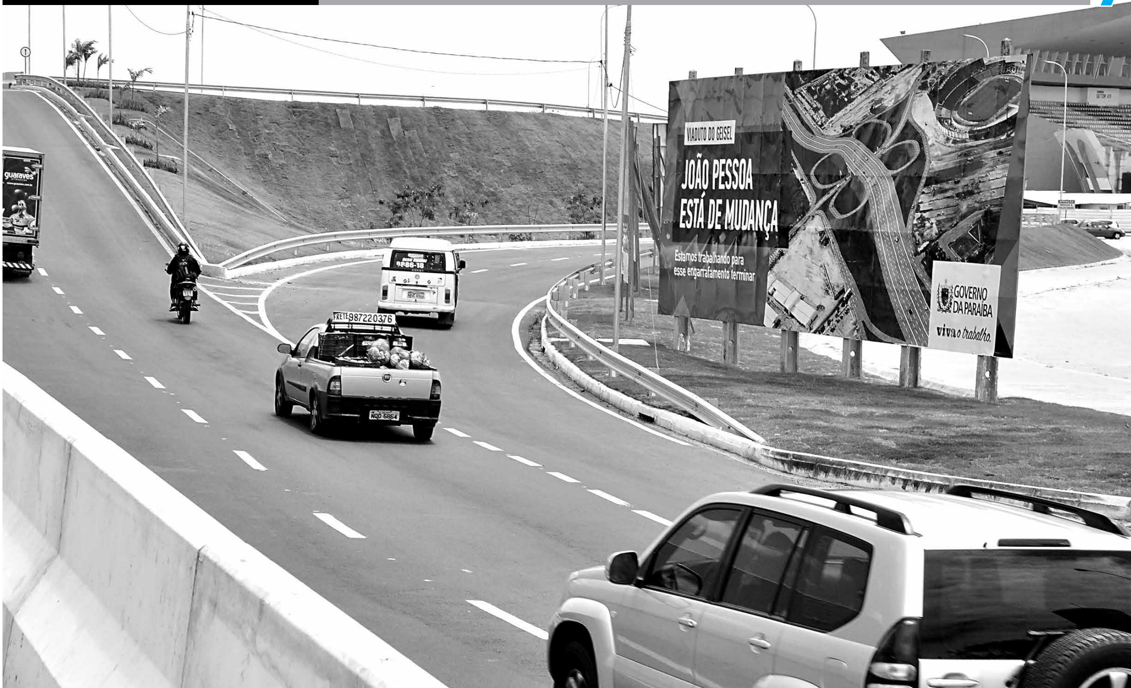
Atualmente os veículos já trafegam pelo viaduto no sentido Cabedelo/Três Lagoas e a partir de sábado o tráfego será feito também no sentido contrário, acabando com parte do congestionamento
