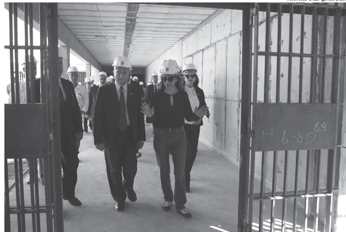
Com 208 celas individuais, a futura Penitenciária Federal de Brasília funcionará em área anexa ao Complexo da Papuda, em Brasília
