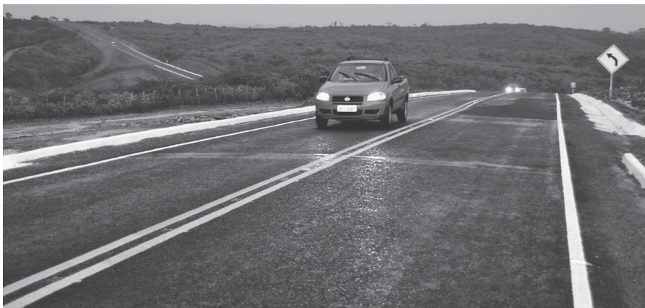
Desde 2014, Casserengue vive uma nova realidade com o acesso asfáltico. A cidade foi a 15ª da Paraíba a sair do isolamento, fato que ainda é comemorado pelos moradores e visitantes.
