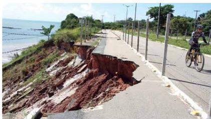
Deslizamento da barreira destruiu parte da rodovia da área interdita há cerca de um ano
