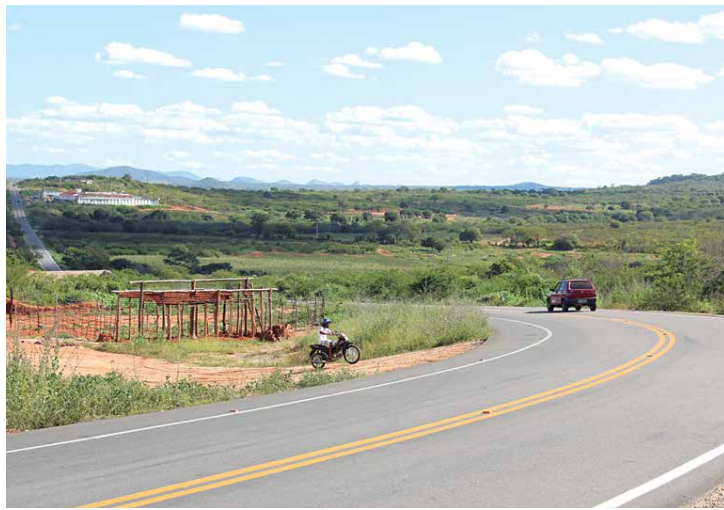
Restauração do contorno, que tira o município de Catolé do Rocha do isolamento, é a 127ª obra rodoviária do programa Caminhos da Paraíba
